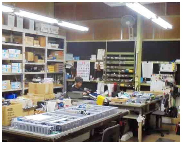
制御盤製作風景
